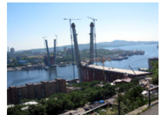
《2012年のAPECを控え、橋の建設が進む》
